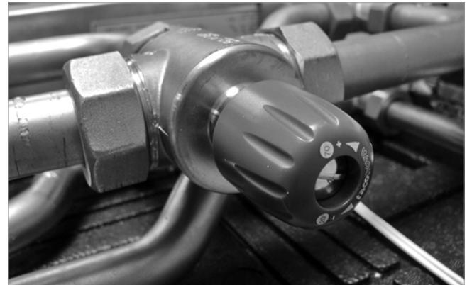
Abb. 10: Thermostatisches Mischventil an der WWS-36
